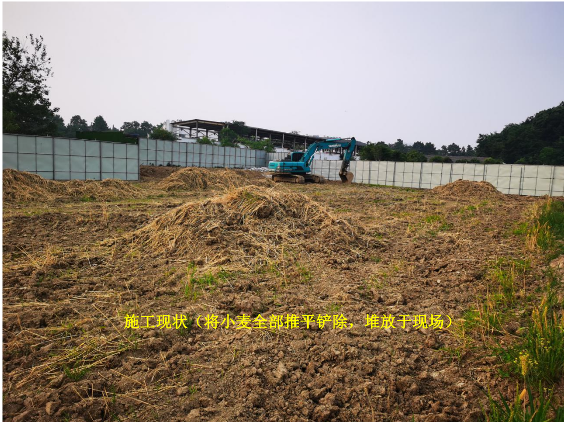
图 4.3-3 调查地块内情况实拍照片
